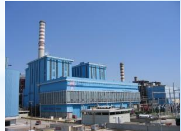
Termovalorizzatore di Fusina (Venezia)
